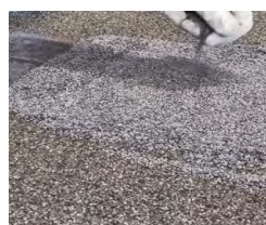
4. Semina a fresco di ardesia in scaglie su ultima mano abbondante di DERMARUBBER S/P, come protezione ai raggi UV
