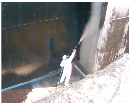
DERMARUBBER S/P: sequenza applicazione a spruzzo su muro di fondazione
